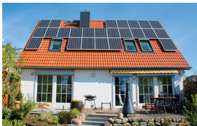
Wärmewende im Heizungskeller: Verbindung von modernster Öl-Brennwerttechnik mit erneuerbaren Energien.
