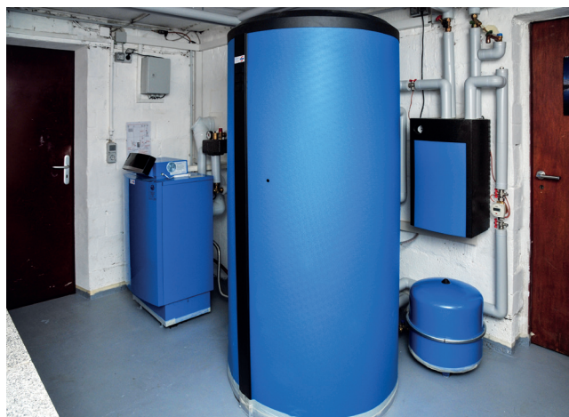
Eine PV-Anlage auf dem eigenen Dach kann nicht nur die Stromrechnung reduzieren, sondern auch die Wärmeversorgung unterstützen.
